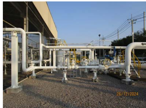
รูปที่ 57 ระบบท่อ Bypass และระบบवालล์สำรอง
