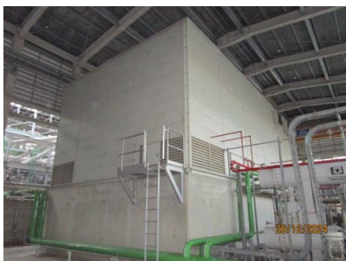
รูปที่ 14 อาคารปิดครอบเครื่องจักรที่มีเสียงดัง
