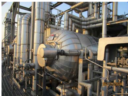
รูปที่ 52 ถังหมั่นเป่าลมไอน้ำและท่อที่ร้อน
