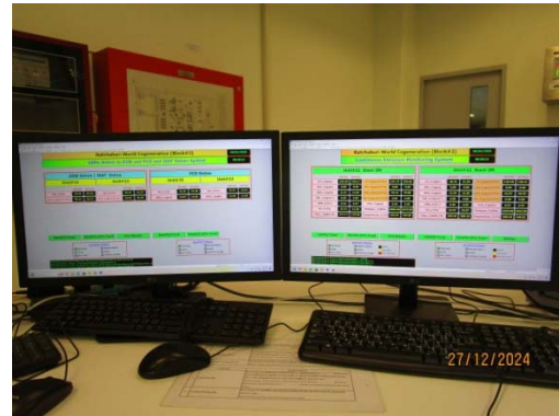
รูปที่ 1 หน้าจอ DCS ระบุค่าสัญญาณเตือนความผิดปกติจาก CEMs
